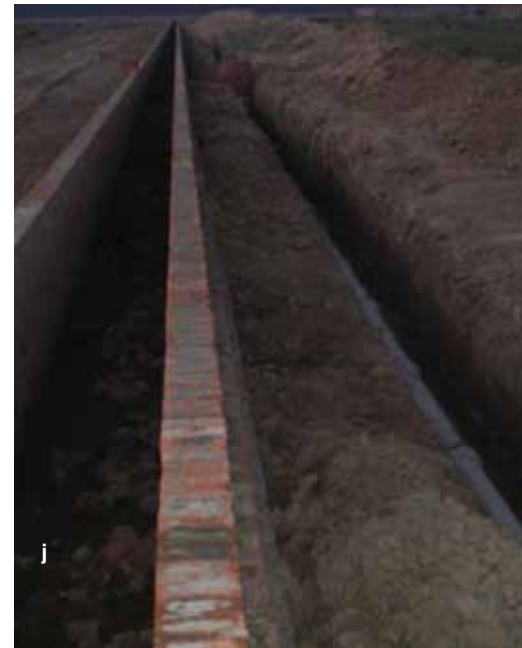
Ci-dessus: i-j. Pose des conduits d'approvisionnement en eau pour BRJP, Patna/ Inde
